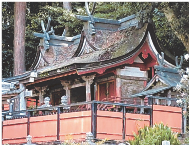
三間社流造の海神社本殿。内部では独立した2棟の建物が並び、これらを覆う屋根が架けられている。宇陀市室生大野で
