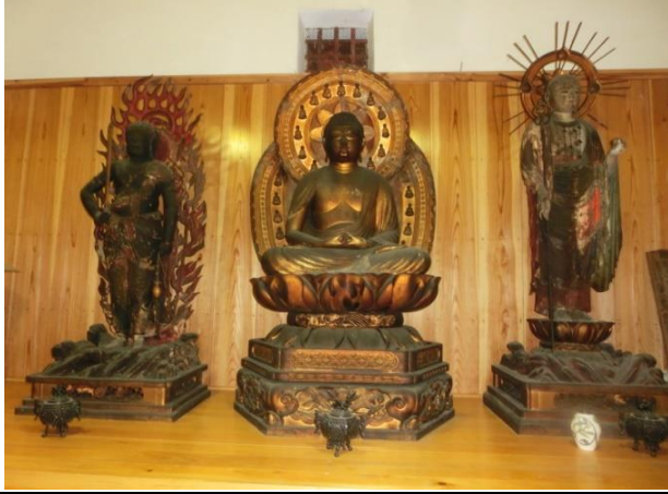
収蔵庫外観。屋根の壁が一部はがれている
