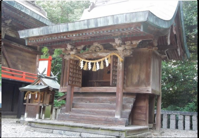
八幡神社本殿土台柱
