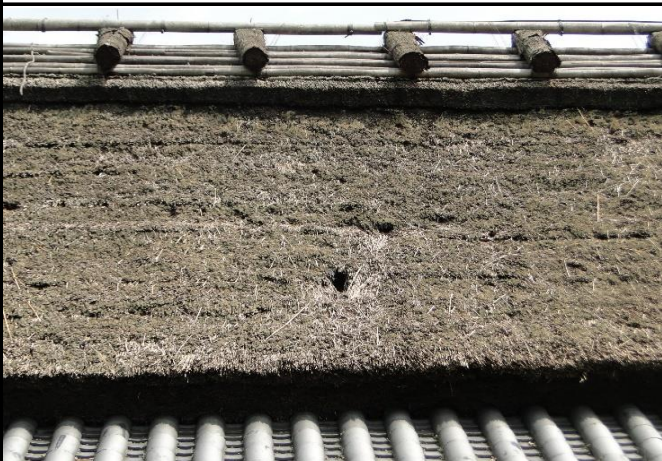
茅葺き屋根に開いたアライグマによる穴(中央下)
