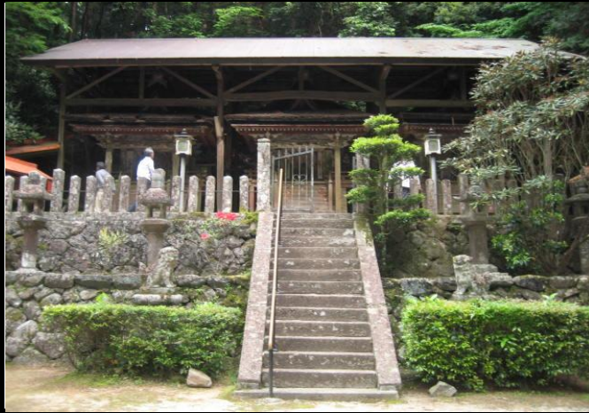
本殿の柱はすべて腐食が進んでいる
