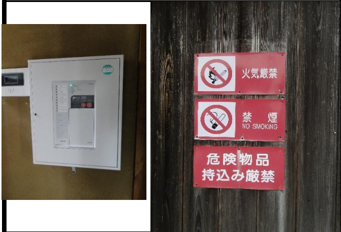
境内の公民館の煙感知機制御盤と防火プレート
