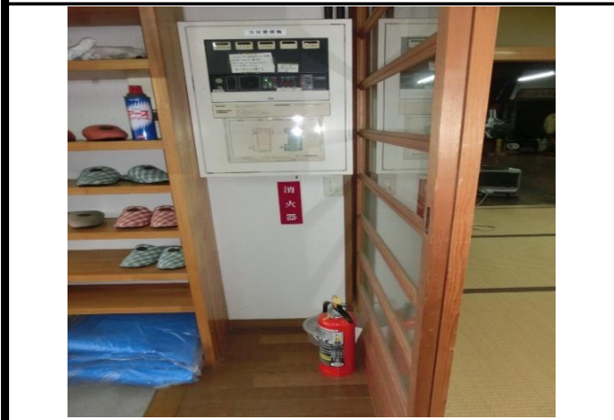
玄関に設置の火災受信機と消火器
