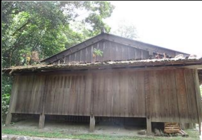
主屋(杉皮葺)と納屋(杉皮葺に補強丸太と石)の屋根
