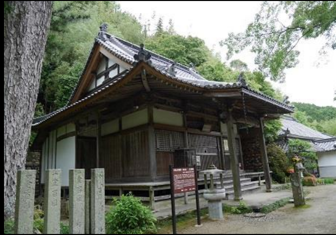
本堂入口脇の消火器
