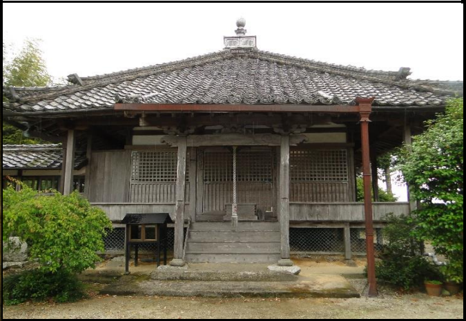
本堂の天井に設置された火災感知機
