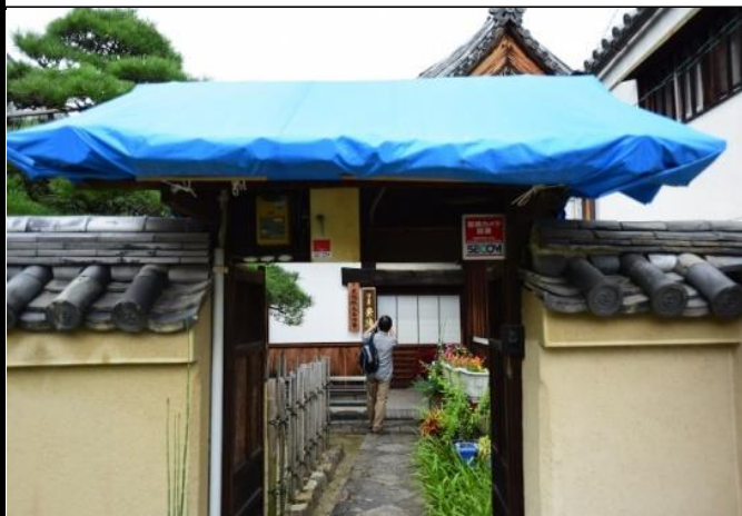
防犯用セキュリティと瓦がずれ落ちるのを防ぐシート
