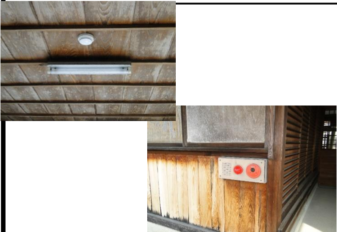
拝殿天井の火災感知器(左上)と火災報知機
