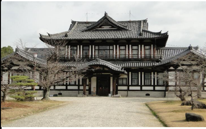
外観は瓦葺きの和風で、瓦上に避雷針を設置
