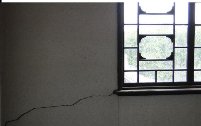
階段踊り場付近の壁面に生じた亀裂
