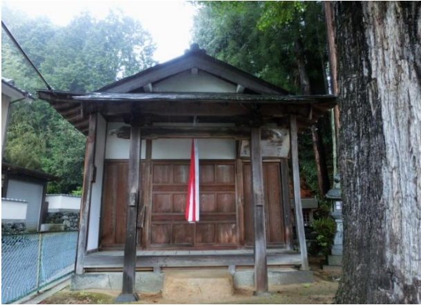
お堂下の排気口(四方に設置されている)
