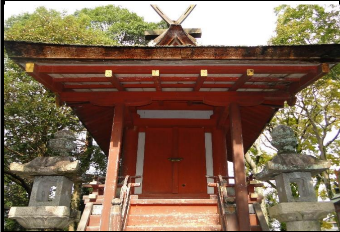
本殿の千木が取れ、屋根全体が後方に傾いている
