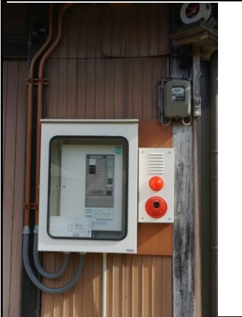
本堂外壁に取り付けられた火災受信所とサイレン
