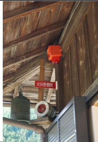
本堂外壁に取り付けられた火災受信所とサイレン
