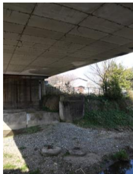
寺川の橋台跡 上は近鉄の橋梁
