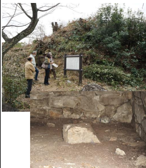
石室内で石の崩落（右下）が起きている平群町の「宮山塚古墳」（2021年2月撮影）
