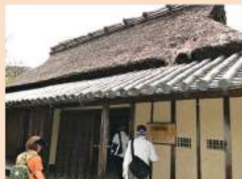
県指定建造物の旧古川家住宅を調査 （大和郡山市の大和民俗公園で2018年8月）
