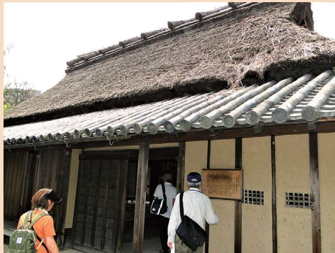
県指定建造物の旧吉川家住宅を調査 (大和郡山市の大和民俗公園で2018年8月)
