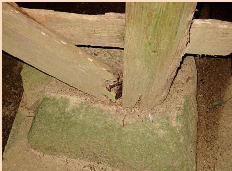
シロアリのため柱が腐食した県指定建造物の平尾水分神社本殿 (宇陀市で2018年5月)
