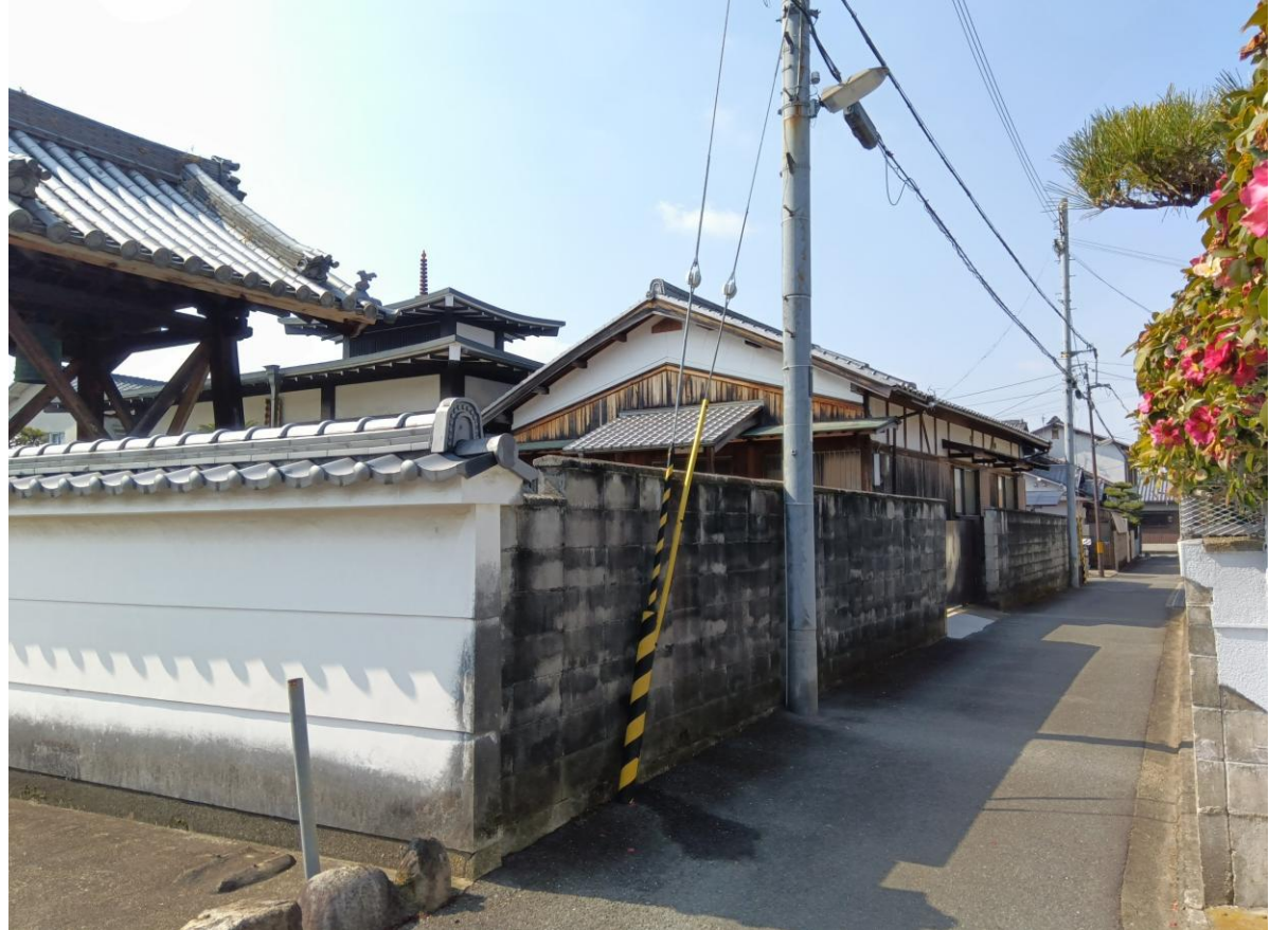
ブロック塀を東から西方向を撮影。西の大阪方面から手前の東方向にB29は飛来したとみられる。
